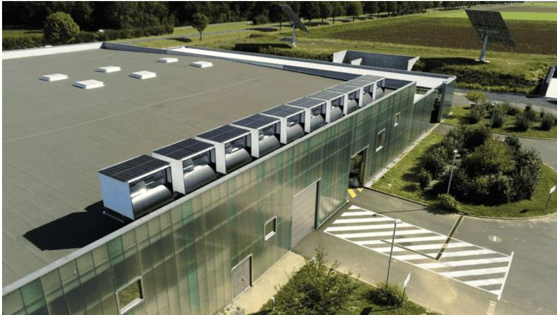
ნახ.1. ქარის და მზის ჰიბრიდული ელექტროგენერატორები კომერციული შენობის სახურავზე
